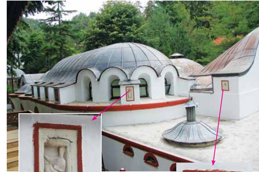
Kurşunlu Hamam'ın kubbe kasağları çevrelerine yerleştirilen çevredeki kazılarda ortaya çıkartılan Antikçağ Stelleri.
