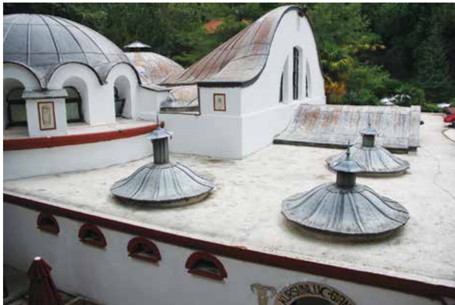
Hamamın kubbe ve tonozları kurşun kaplı olduğu için Kurşunlu Hamam'ı olarak adlandırılmıştır.
