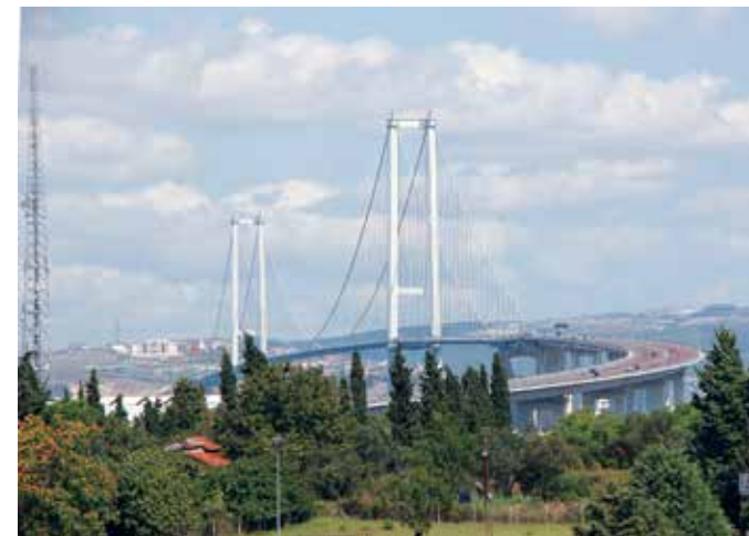
Yeni yapılan Osmangazi Köprüsü Hersek Kuş Lagünü'nün doğal ortamını bozmamak için kavisli yapılmıştır.
