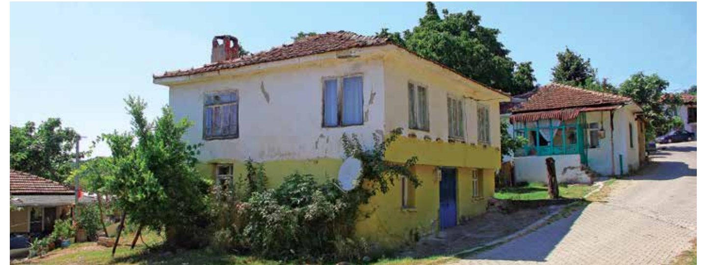
Geleneksel Akköy evlerinin, zemin katı düzgün kesme taş örgülü, üst katı ahşap karkas arası tuğla dolguludur.
