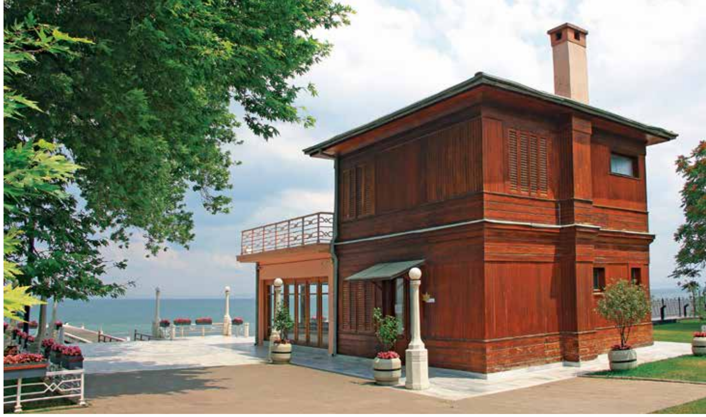
Yürüyen Köşk güneybatı köşesinden
