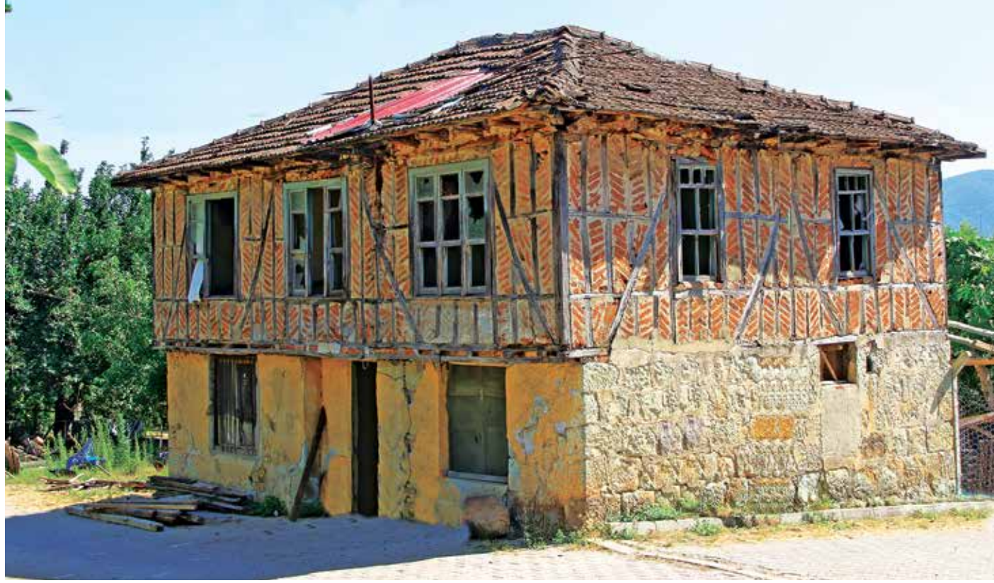
Akköy'de yıkılmaya yüz tutmuş bir eski ev
