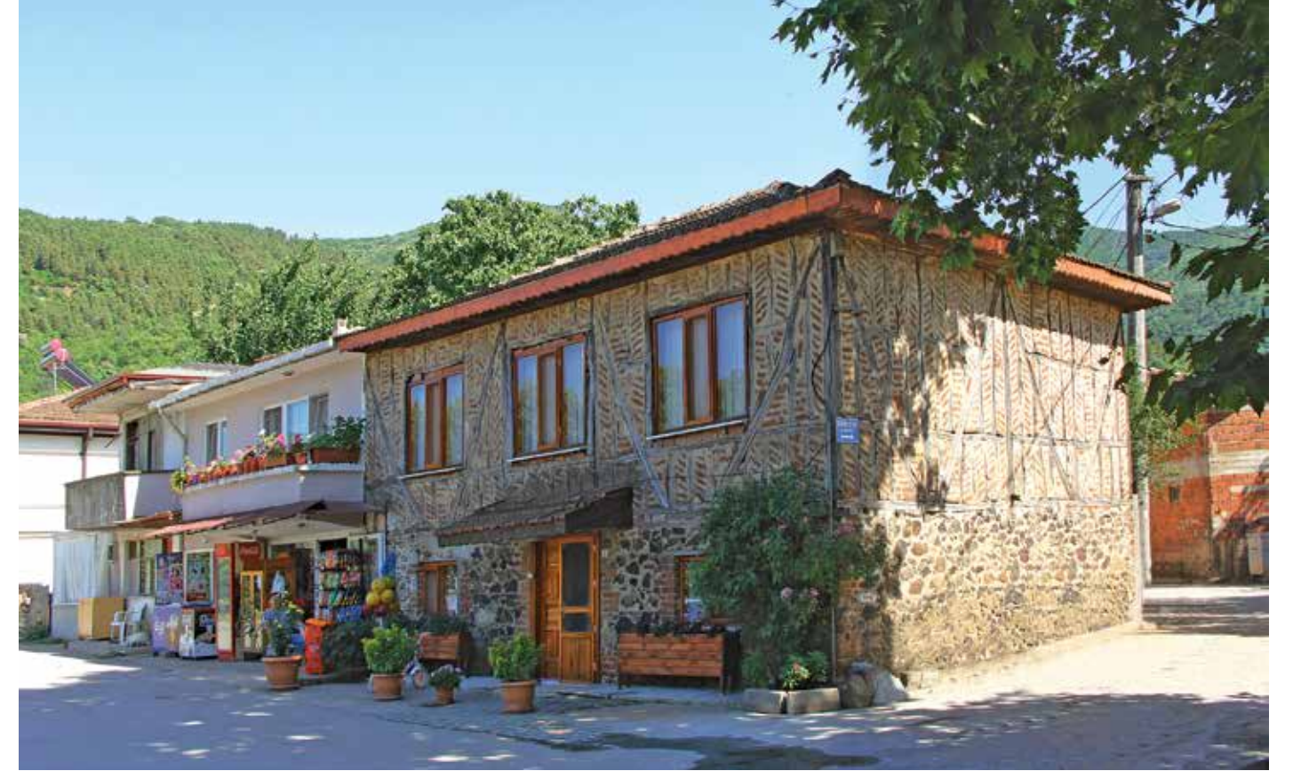
Kocadere köy meydanındaki tarihî çınarın ve kahvehanenin yanındaki geleneksel yapıdaki eski bir ev restore edilmiş olarak işlevini sürdürüyor.
