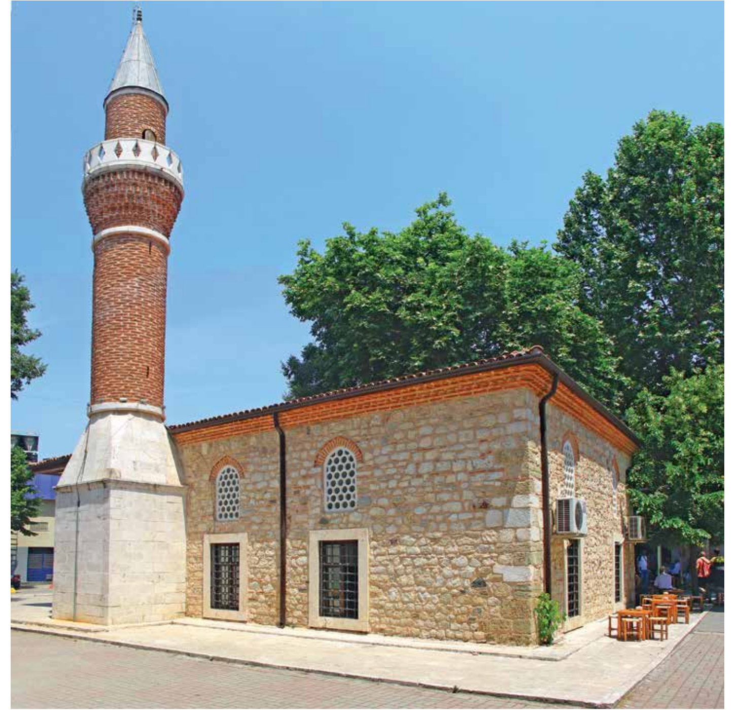
Rüstem Paşa Camii son haliyle batıdan
