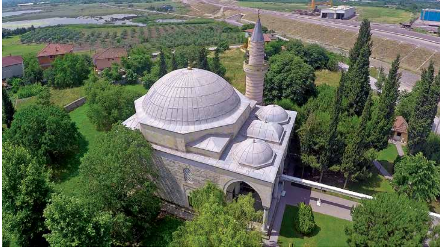
Külliye'den bugün geriye cami, hamam ve su deposu kalmıştır. Kayıtlarda adı geçen kervansaray, imaret, mektep ve medreseden ise iz yoktur.
