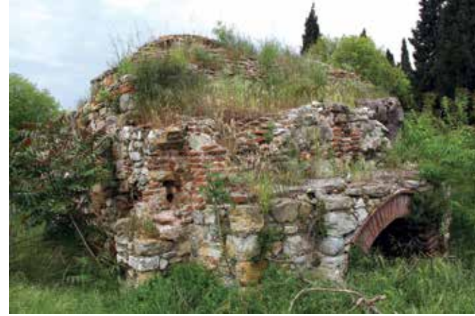
Hamamın arka tarafında külhan bölümü
