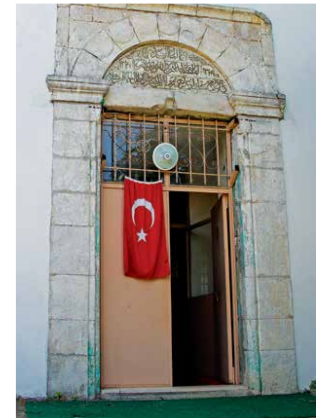
Caminin, üzerinde tamir kitâbesinin yer aldığı yüksek giriş kapısı
