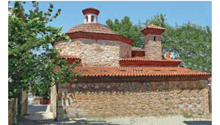
Gacık Köyü Hamamı, güneyden
