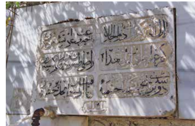
Armutlu'da İskele mevkiinde bulunan Eski Çeşme ve kitâbesi
