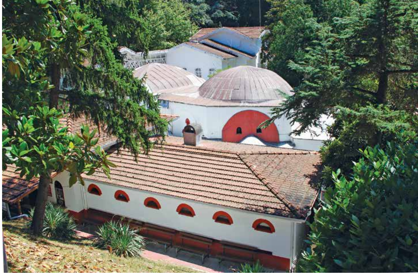
Vâlîde Hamamı'nın batıdan görünüşü.
