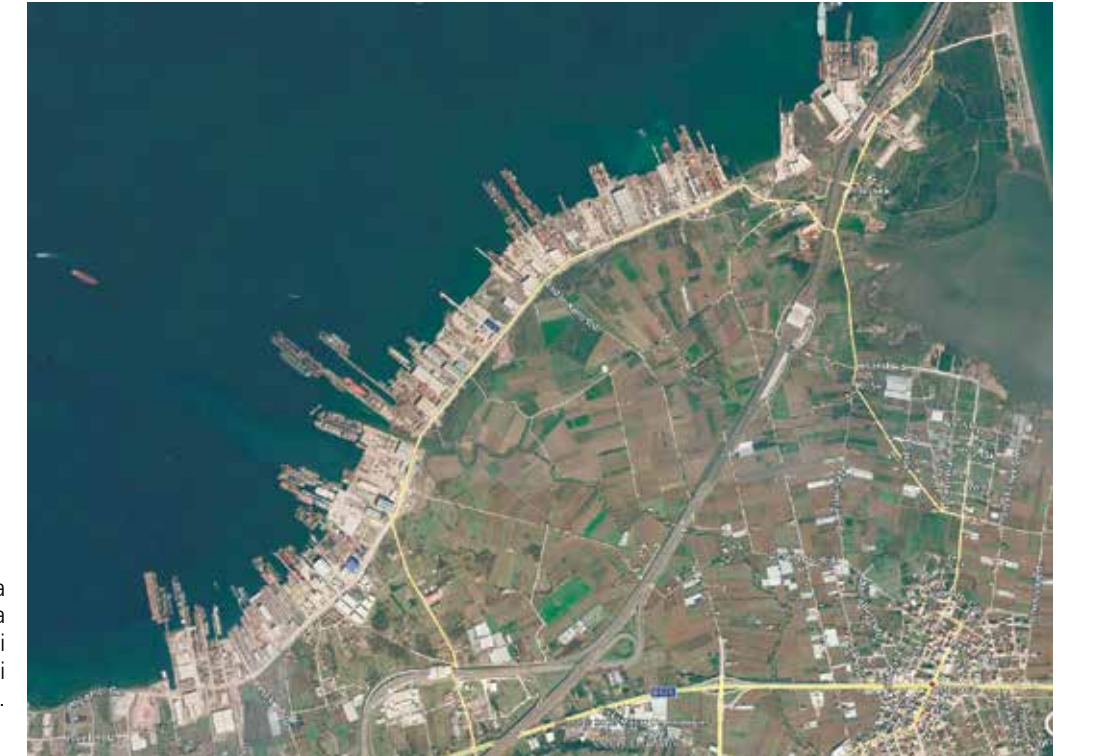
Altınova'da Hersek kıyılarında faaliyetine devam eden, Yalova ve Türkiye ekonomisi için önemli bir yeri olan gemi tersaneleri bölgesinin konumu.
