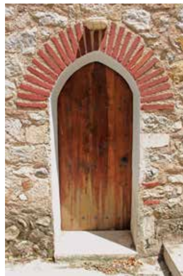
Hamamın giriş kapısı
