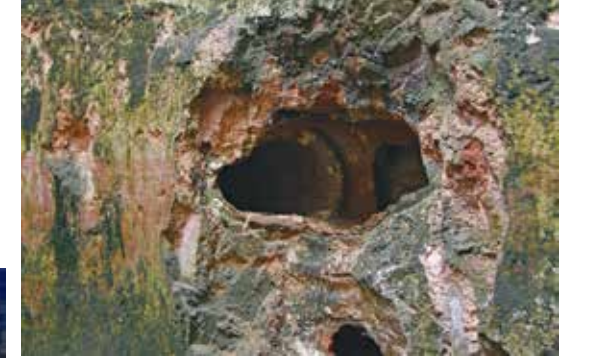
Hamamın duvarlarını içinden geçen su künkleri ortaya çıkmış durumda
